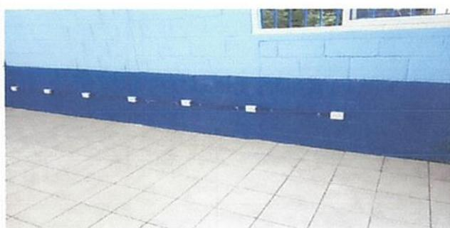
Foto 2: Mejoramiento sistema Electrico, entubar 20 metros lineales de cable No. 10.
