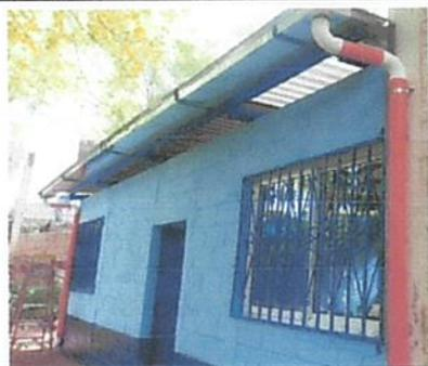
Foto 5: Colocación de Canales y Caidas de Agua
