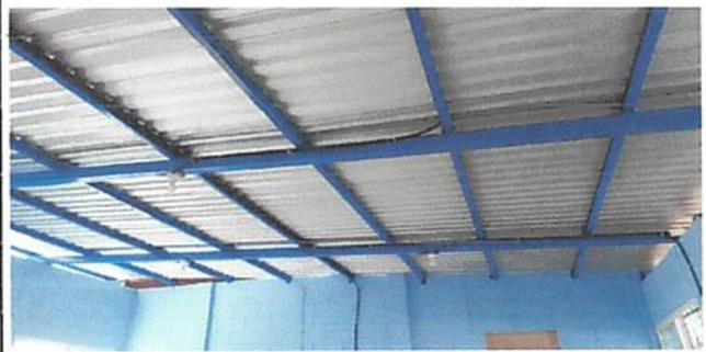
Foto 1: Cambio de Techo con lamina Troquelada Calibre 26 y refuerzo de Costanera.
